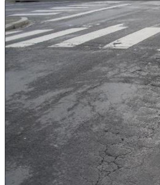
Il est répandu une émulsion de bitume et de gravillons. Un balayage des gravillons non agglomérés est réalisé systématiquement 3 semaines après la mise en œuvre.
